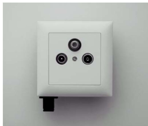
Bild 2 Netzabschlussdose als WÜP
