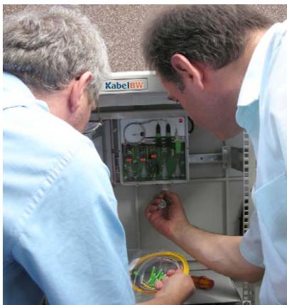
FTTB-Pilotprojekt, Einpegelung mit Kabel BW
